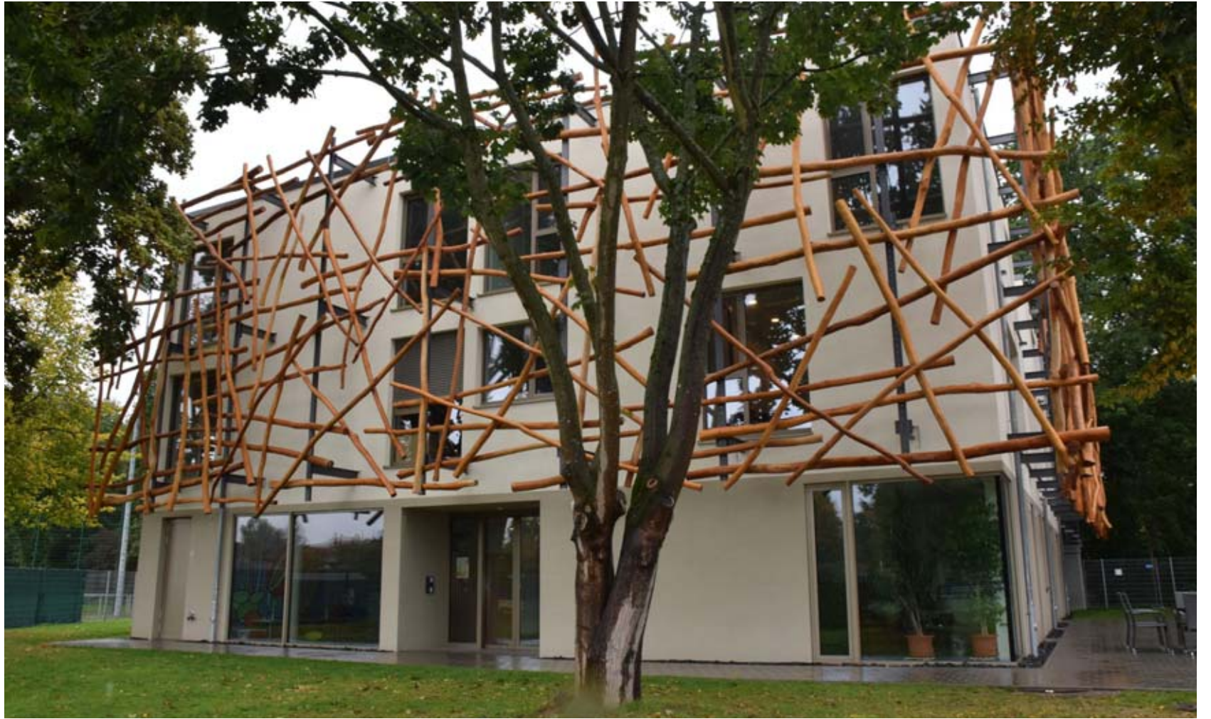
Die wie ein Schwanennest angebrachte Robinienholz-Fassade beeindruckt.
