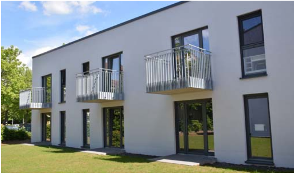
Außen hui und auch innen hui: Das neue Johannes-Staubner-Haus wurde gestern Mittag eingeweiht. FOTOS: HOLGER HACKENDAHL
